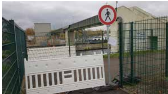
Der Wehrsteg an der Schleuse in Gustavsburg ist gesperrt
