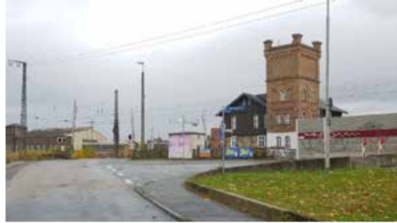
Die vorbereitenden Bauarbeiten zur Rad- und Gehwegunterführung beginnen
