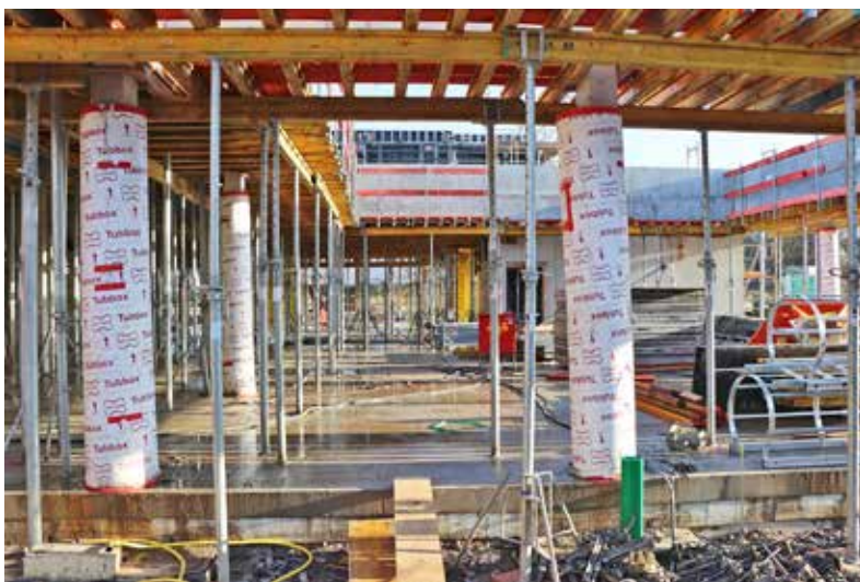
Noch ist es eine Großbaustelle, aber die Flächen für Mensa und Ausbildungsrestaurant an der Georg-Mangold-Schule in Bischofsheim sind bereits gut zu erkennen. Foto: Kreisverwaltung
