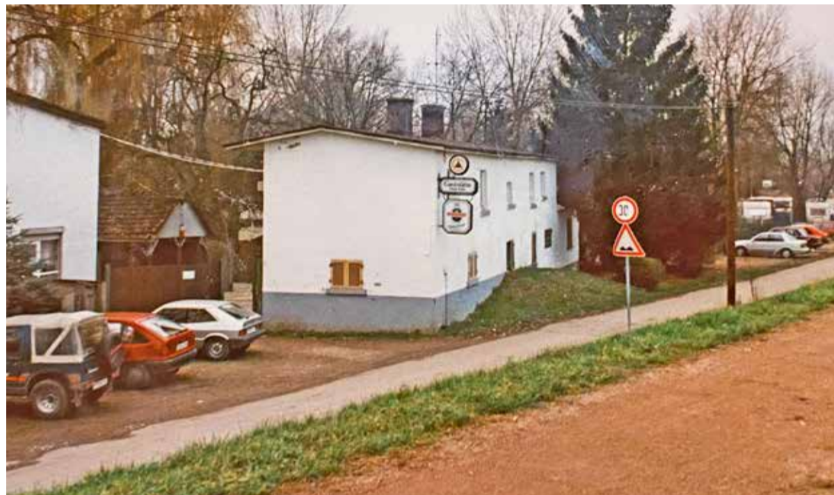
Das Gebäude im Bleiauweg vor Start des Komplettumbaus und Sanierung
