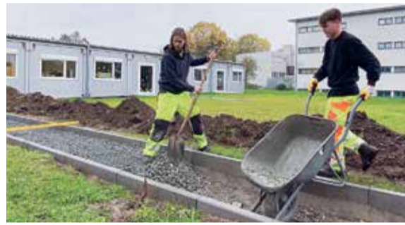
v.l.n.r.: Jonathan Soßdorf und Nils Fischer, beide Auszubildende beim Servicebetrieb Bauhof, beim Anlegen des neuen Weges an den neuen Containern der Schulkinderbetreuung in Ginsheim
