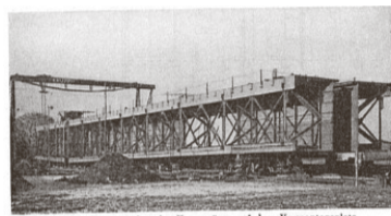
Bild 5: Zusammenbau der Hauptträger auf dem Vorkonstruktionsplatz
