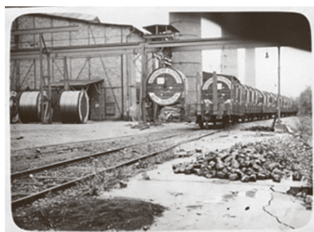
1928 Verladung eines Hohlseiles 2
